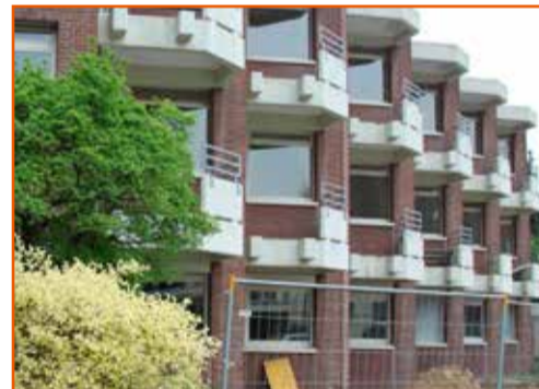
Die ursprünglichen Balkone an der Hausseite wurden teilweise ersetzt
