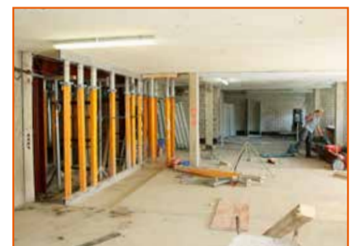
Um Platz zu schaffen, wurden Wände eingerissen und woanders hochgezogen
