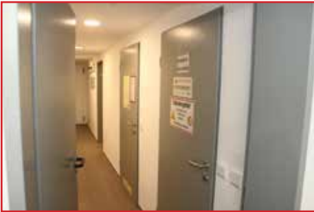
September 2018: Auch der Keller ist vorzeigbar; Kühlraum und ganz viel Technik sorgen dafür, dass im Haus St. Anna wieder gekocht werden kann
