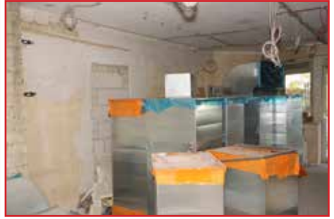
Oktober 2017: Die Lüftungsanlage der Küche wartet auf die Montage
