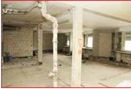
Ein halbes Jahr später: Im April 2017 stand nur noch der Rohbau
