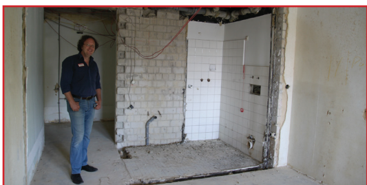
Vor zwei Monaten haben hier noch Bewohnerinnen und Bewohner gewohnt. Mittlerweile ist hier die Baustelle im vollen Gange
