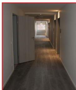
Der 2. Bauabschnitt ist fast fertig
