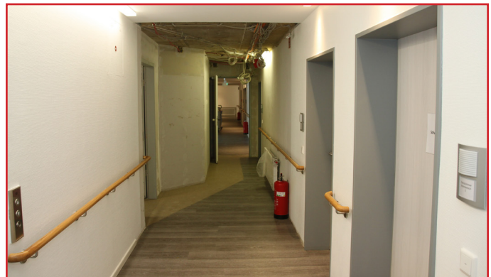
Dass der Umbau fast geschafft ist, zeigt dieses Bild - nur ein kleiner Streifen Baustelle trennt die fertigen Bereiche voneinander
