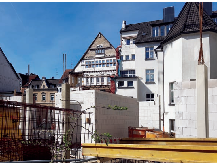
Aktuell wird das Liebfrauenstift umgebaut.
