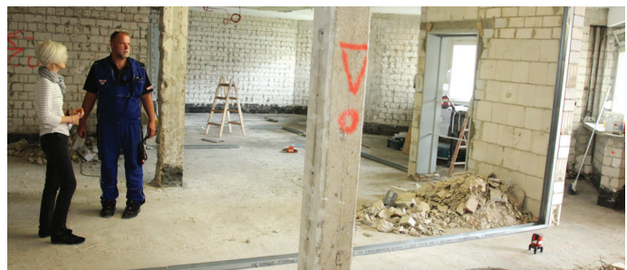
Die Schiene im Boden zeigt, wo bald Essen ausgegeben wird
