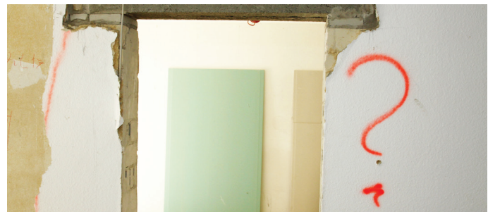
Wand und Türöffnung sind da; hier entsteht der Friseursalon
