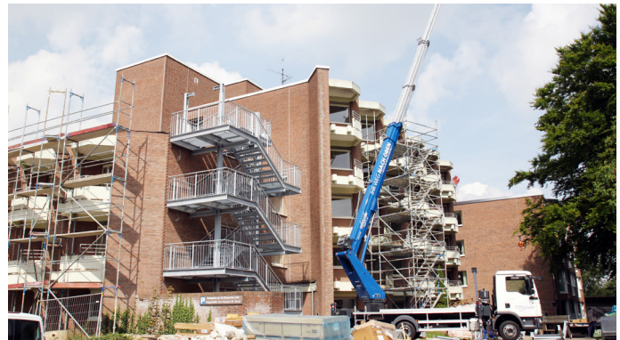
Eine Seite des Hauses ist schon fertig; rund um die neue Rettungstreppe wird noch fleißig gearbeitet.
