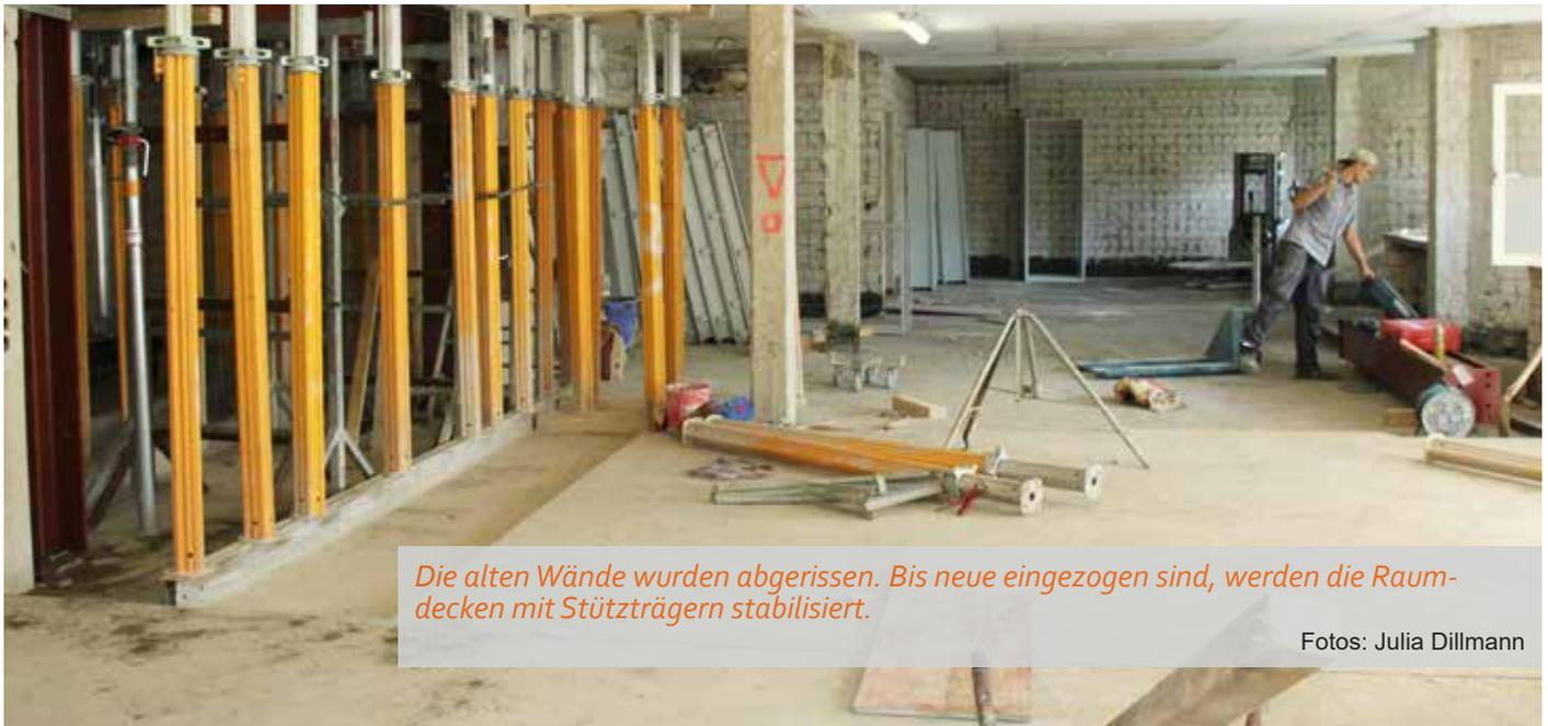
Die alten Wände wurden abgerissen. Bis neue eingezogen sind, werden die Raumdecken mit Stützträgern stabilisiert.
