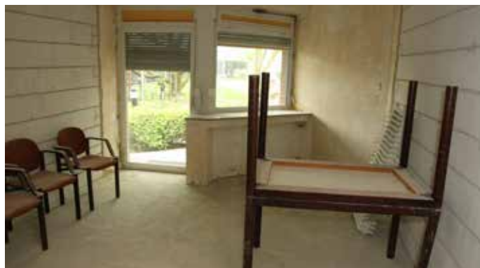
April 2017: Derselbe Raum mit Zwischenwänden
