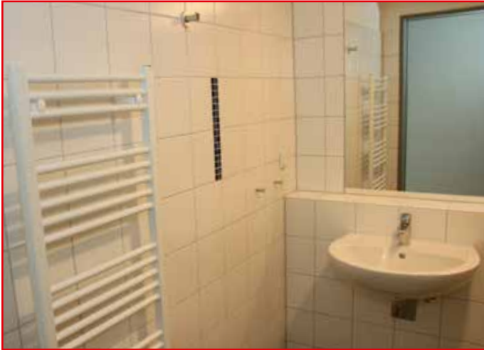
Fertig gefliest und einsatzbereit: die Bäder der Bewohnerzimmer – jedes Bewohnerzimmer verfügt über ein eigenes Bad
