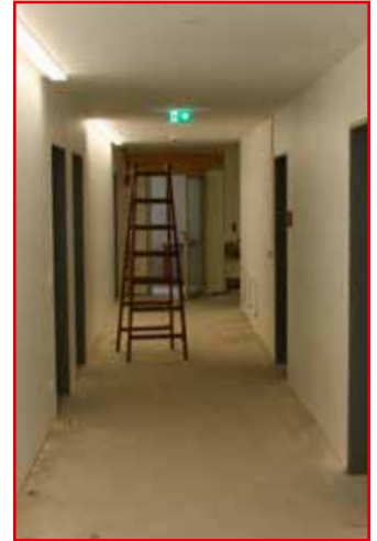
Im Erdgeschoss sind die Bauarbeiten noch nicht so weit
